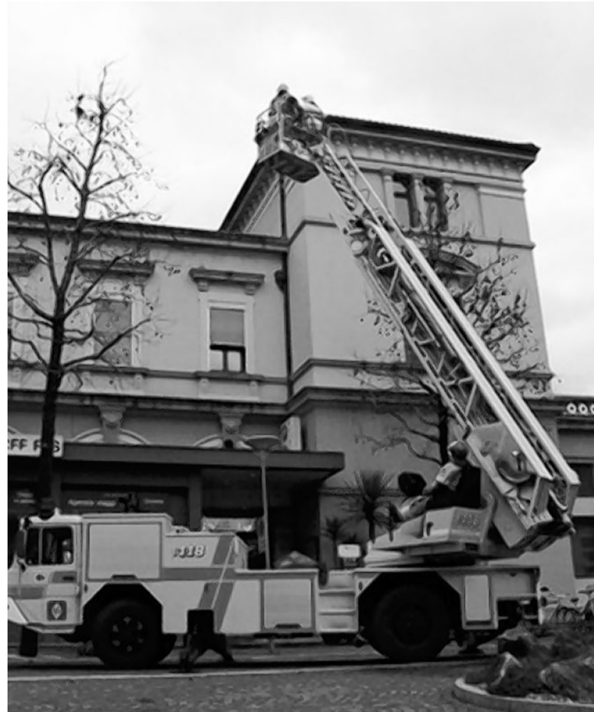
Un recente intervento presso la stazione a Muralto
